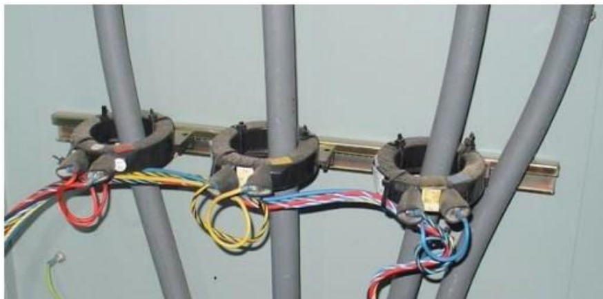
Slika 1. Primjer jednostavne izvedbe NN provlačnog SMT-a [4]
