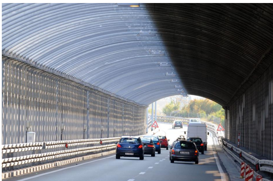
Slika 7.1. Zid za zaštitu od buke na Riječkoj obilaznici
