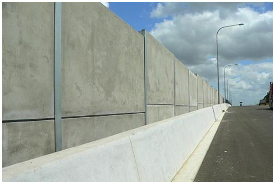
*Slika 6.6. Armirano-betonski paneli*
