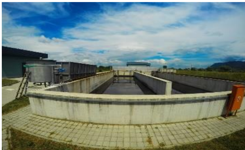
Slika 5. Primarna taložnica (UPOV Zaprešić, 2017).
