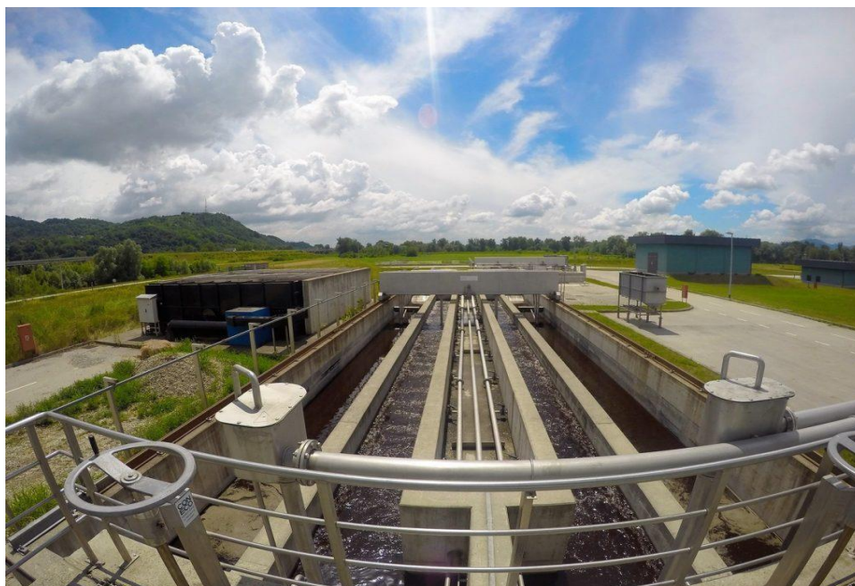
Slika 6. Pjeskolov i mastolov (UPOV Zaprešić, 2017).
