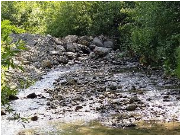
Slika 84. Proširivanje ceste nasipavanjem
