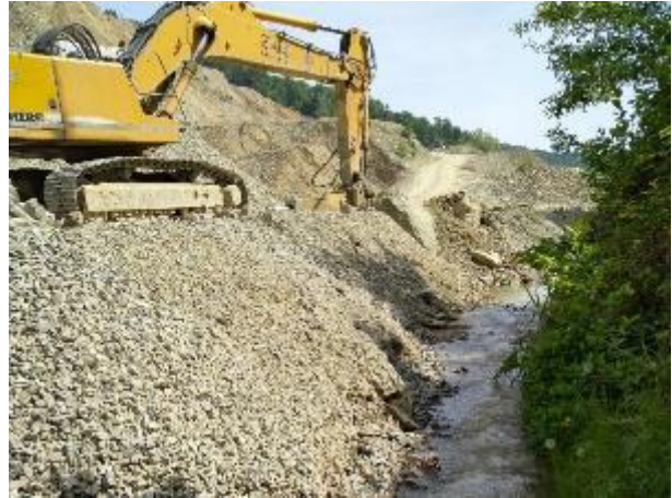
Slika 83. Proširivanje ceste kamenoloma nasipavanjem
