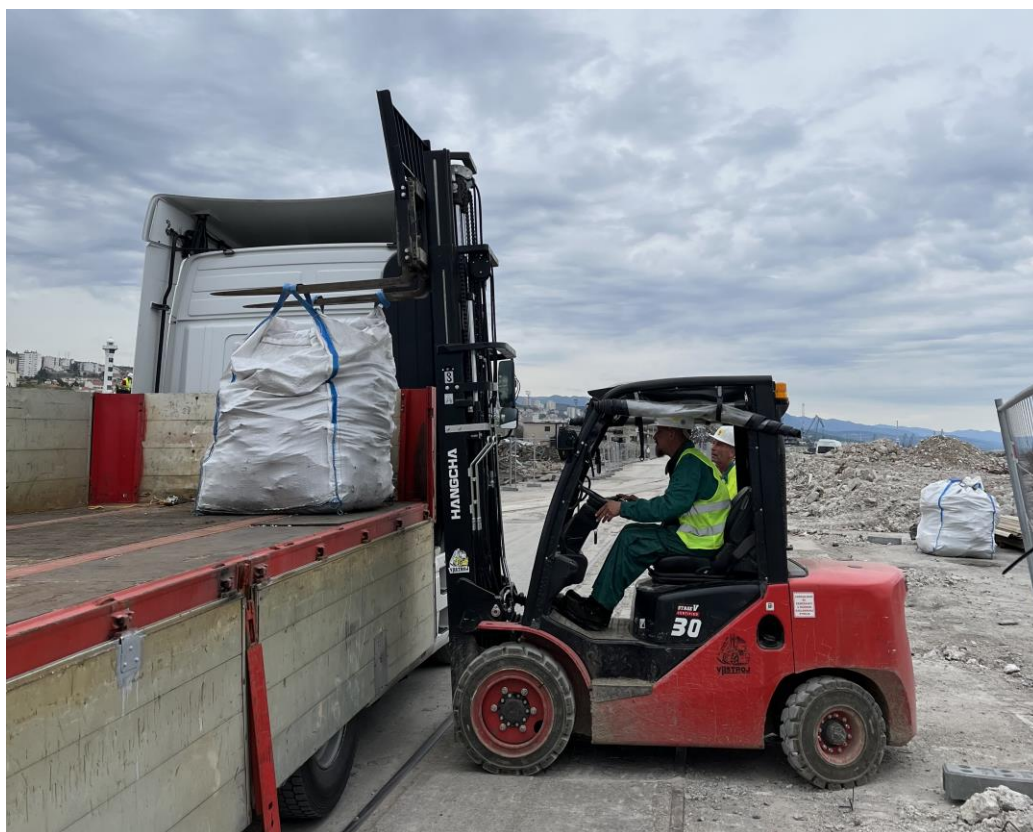
Slika 8. Odvoz građevinskog materijala koji sadrži azbest [2]
