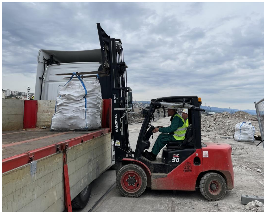
Slika 8. Odvoz građevinskog materijala koji sadrži azbest [2]
