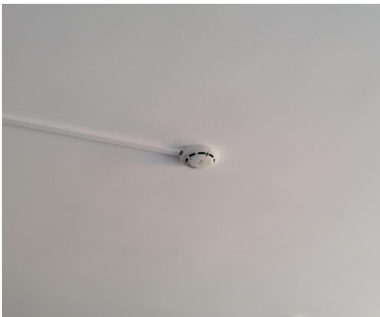
Slika 17. Primjer detektora dima
