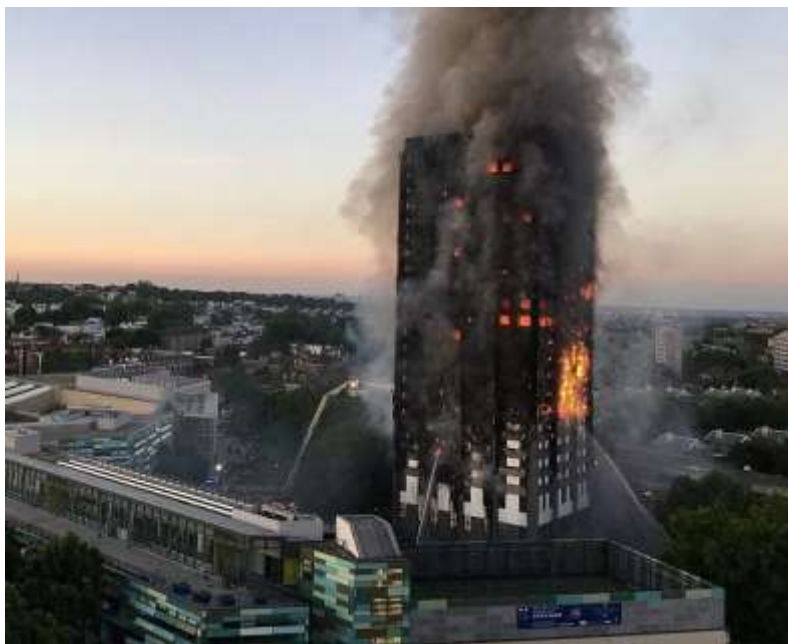
Slika 9. Požar u Grenfell Toweru [16]
