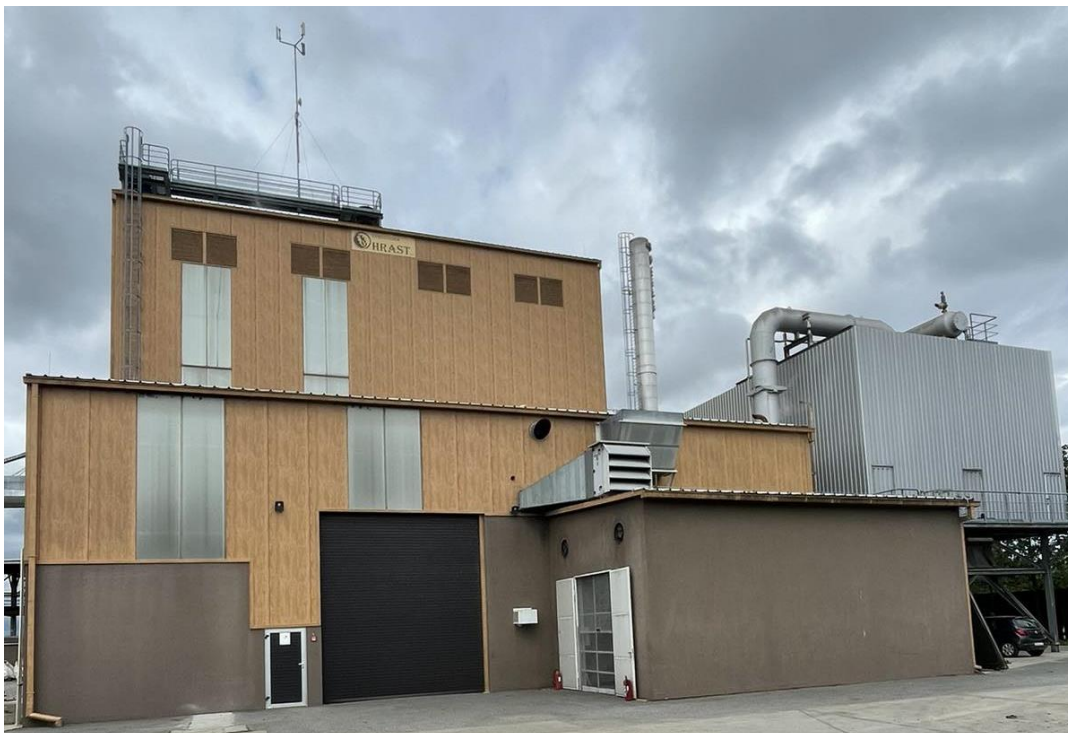
Slika 3. Kogeneracijsko postrojenje tvrtke "Strzivojna-Hrast d.o.o." [5]
