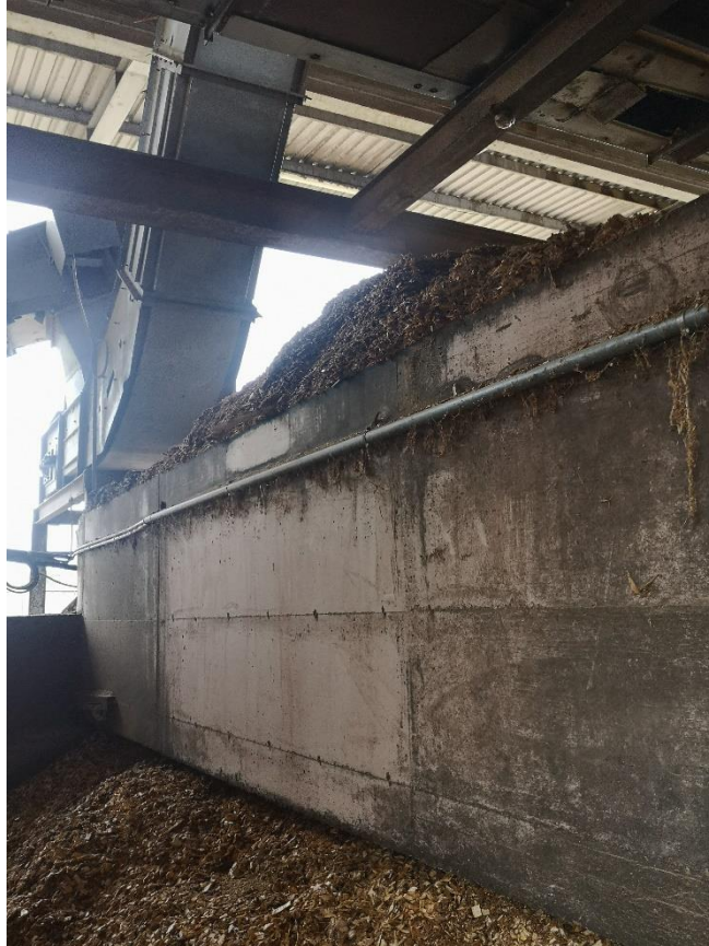
Slika 29. Termički javljač u dnevnom spremniku sječke [5]
