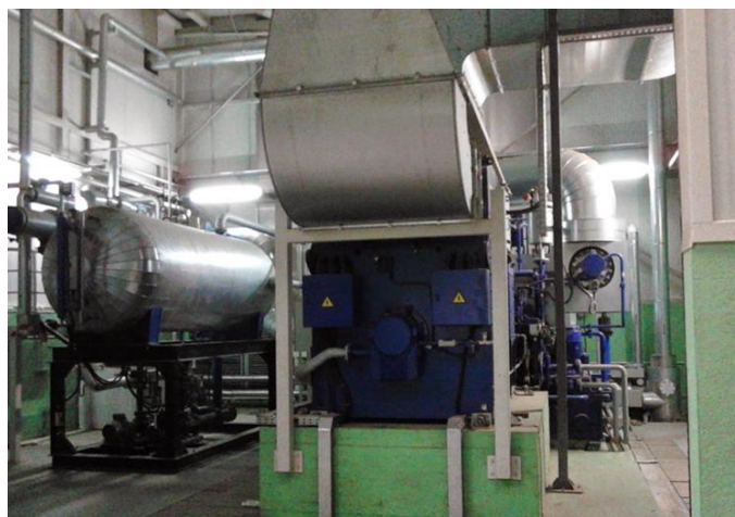
Slika 11. Turbina, generator [5]
