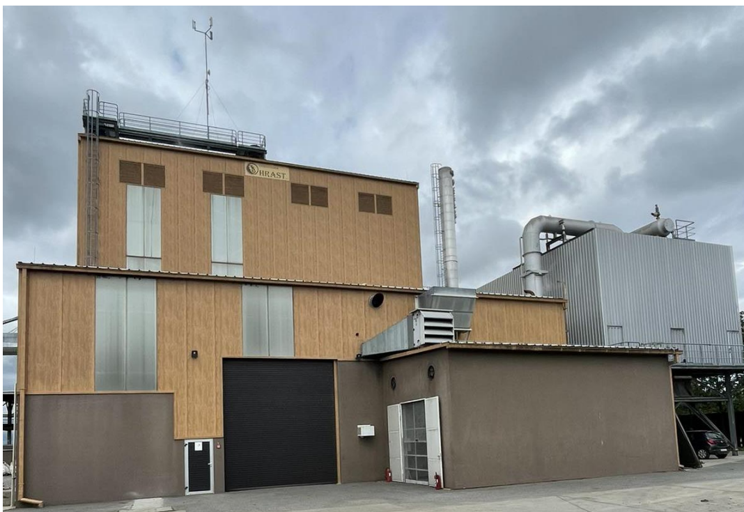
Slika 3. Kogeneracijsko postrojenje tvrtke "Strzivojna-Hrast d.o.o." [5]
