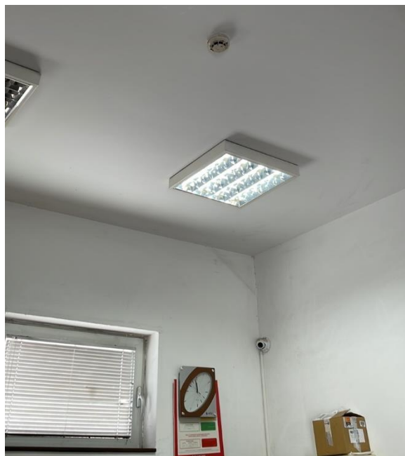
Slika 28. Optički javljač u kontrolnoj sobi [5]
