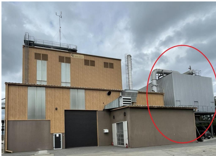
Slika 10. Zračni kondenzator [5]
