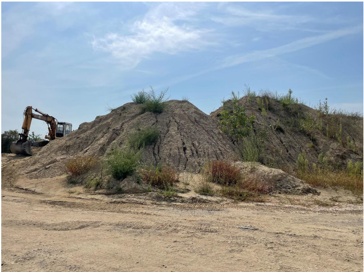
Slika 19: Rast invazivnih biljnih vrsta u nasutoj zemlji na gradilištu (Izvor: vlastiti)
