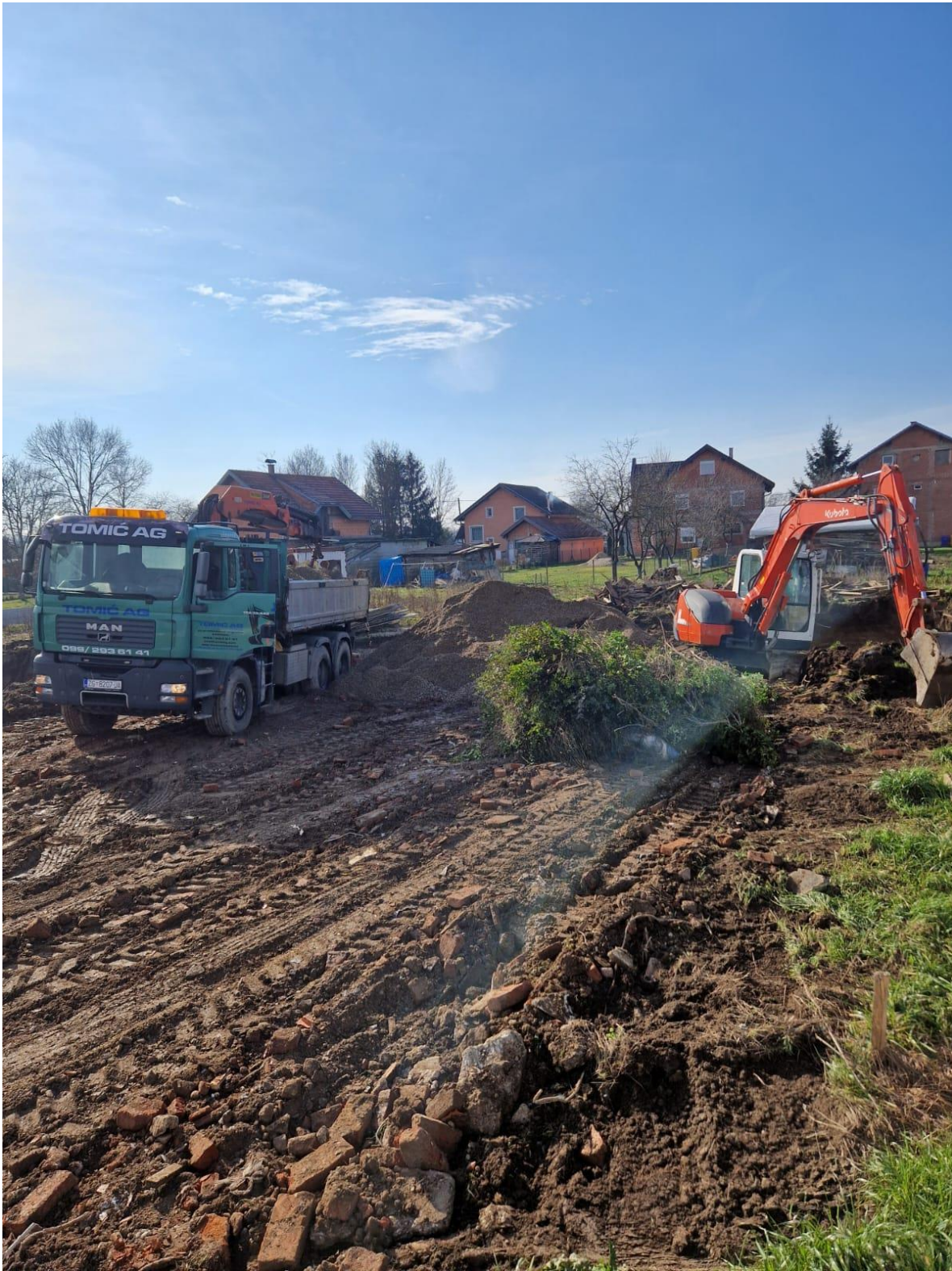
Slika 14: Priprema građevinskog zemljišta (Izvor: Vlastiti)
