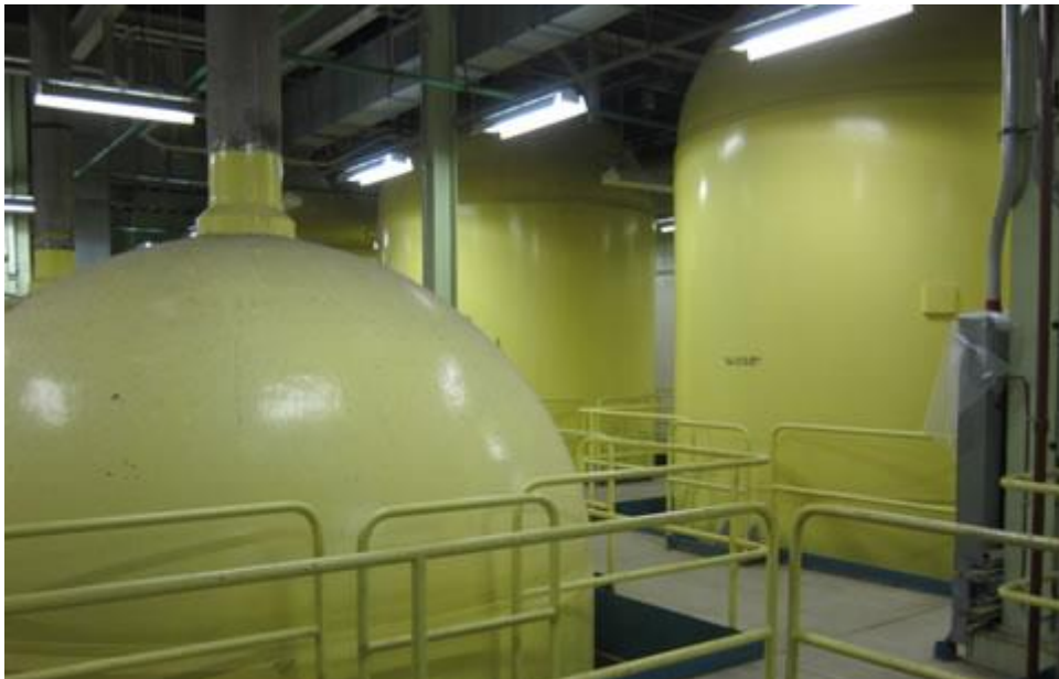
Slika 7. Spremnici dušika pod tlakom za hitne slučajeve [9]
