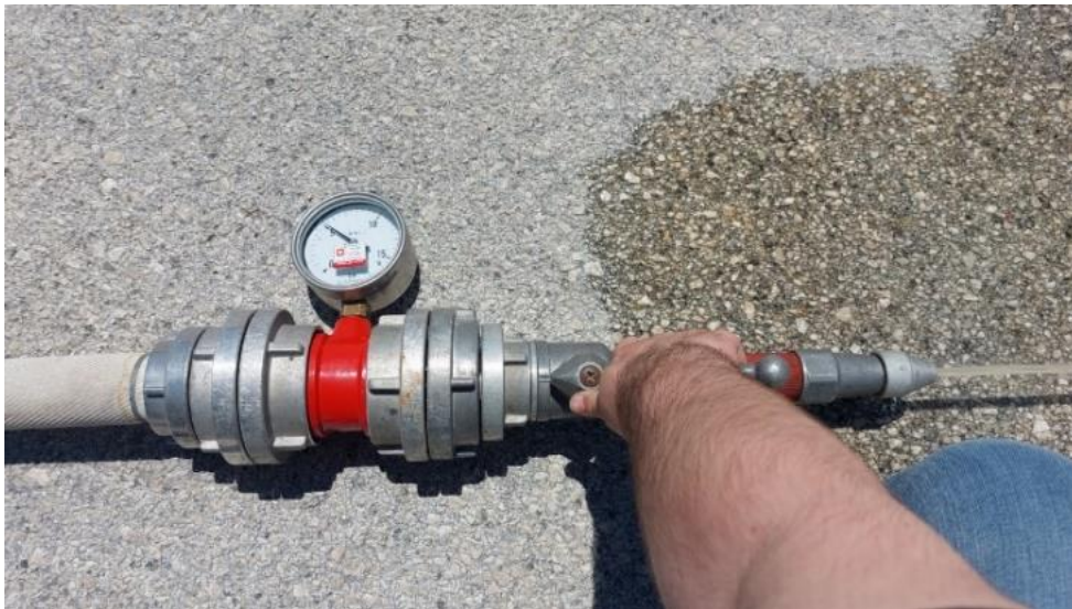
Slika 17. Ispitivanje hidrantske mreže(QH-linija) [8]
