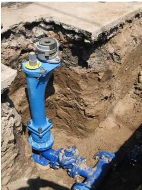
Slika 14. Podzemni hidrant [8]
