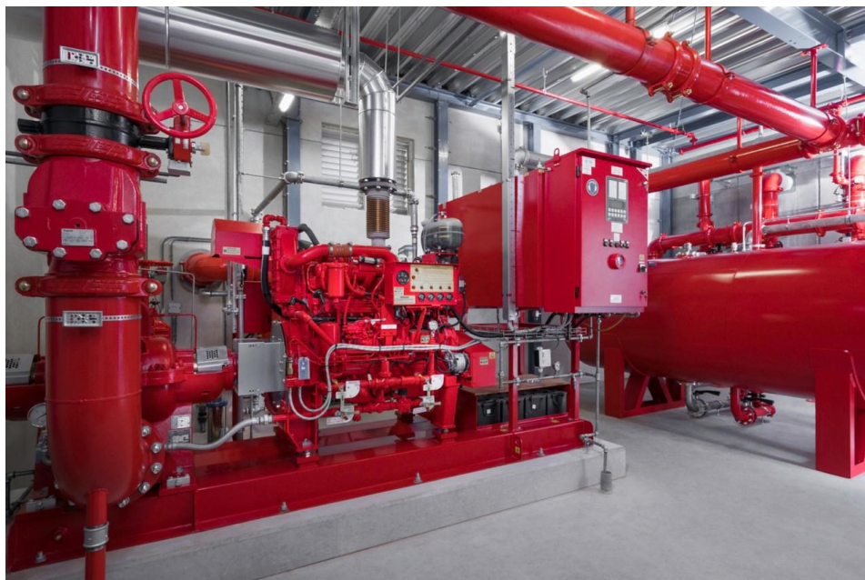
Slika 23. Predodžba protupožarne pumpne stanice [46].
