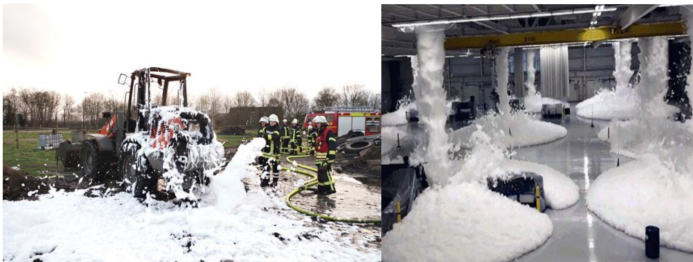
Slika 3. Pjena kao sredstvo za gašenje požara ( https://tehnoplam.hr/usluge/stabilni-protupožarni-sustavi/ )
