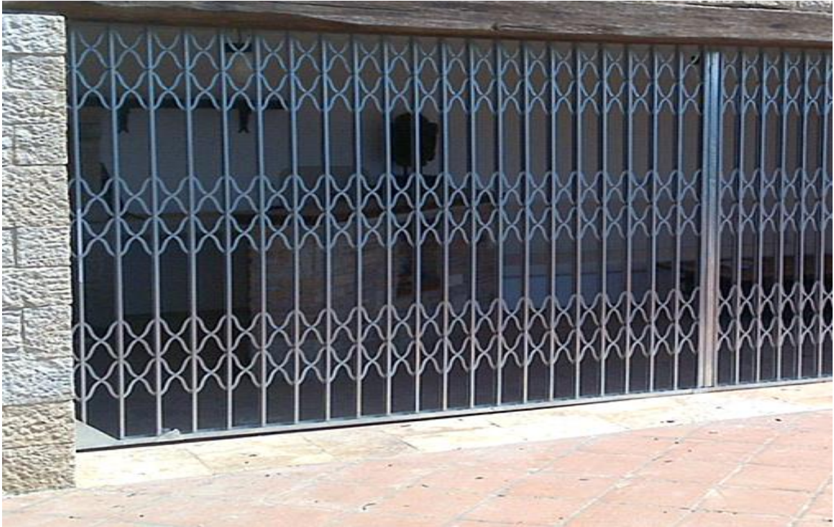
Slika 7. Primjer harmonika vrata TIP ORIENTE [1]
