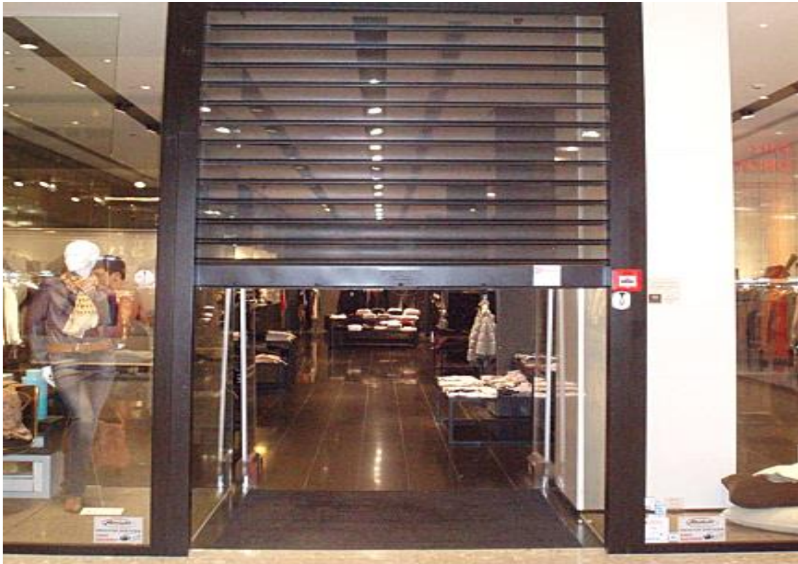
Slika 22. Primjer ravnog profila [1]
