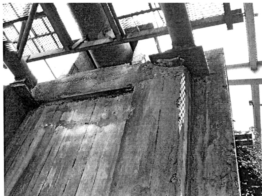
**Slika 10. Oštećenja betonskih oslonaca noseće konstrukcije – Podsused**
