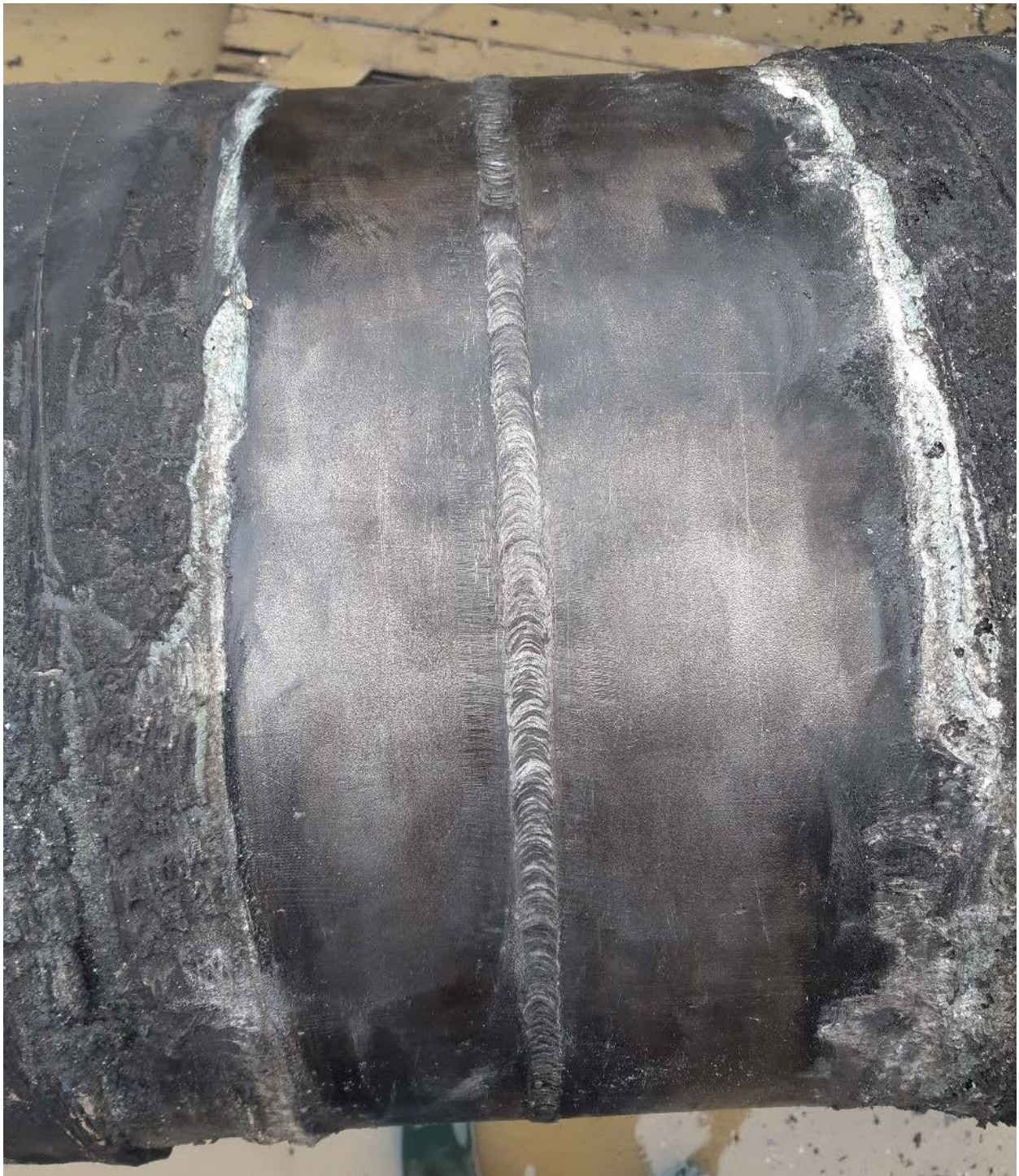
Slika 25. Sučeoni zavareni spoj i okolni osnovni materijal
