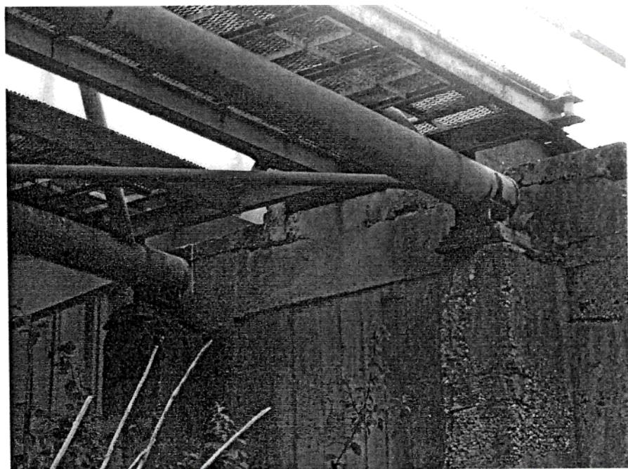
**Slika 12. Oštećenje betonskih oslonaca noseće konstrukcije – Rakitje**
