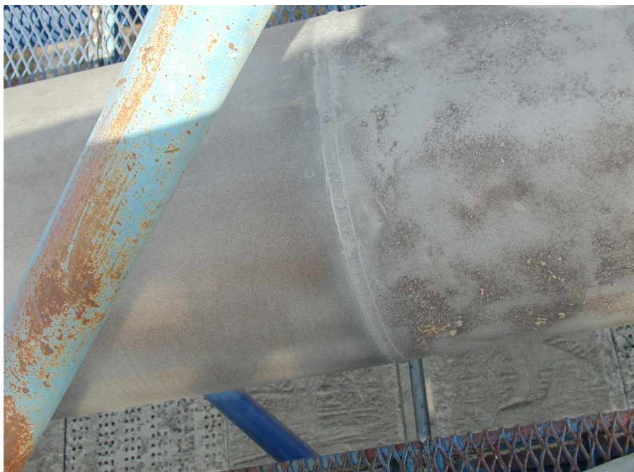
Slika 20. Korozijska oštećenja
