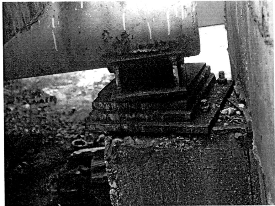
**Slika 11. Pomak ploča na kliznom osloncu noseće konstrukcije – Rakitje**
