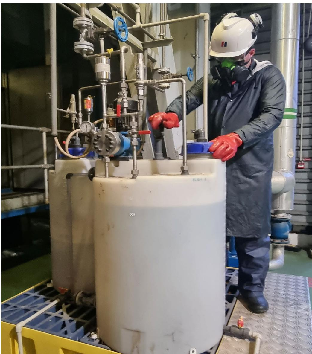
Slika 17. Dozirna stanica za kondicioniranje napojne vode plinske termoelektrane PTE1 i PTE2 [24]
