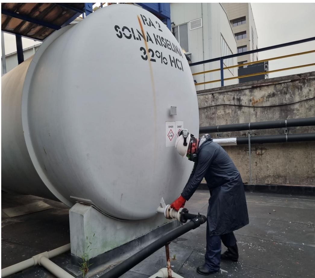
Slika 10. Zatvaranje ručnog ventila [16]
