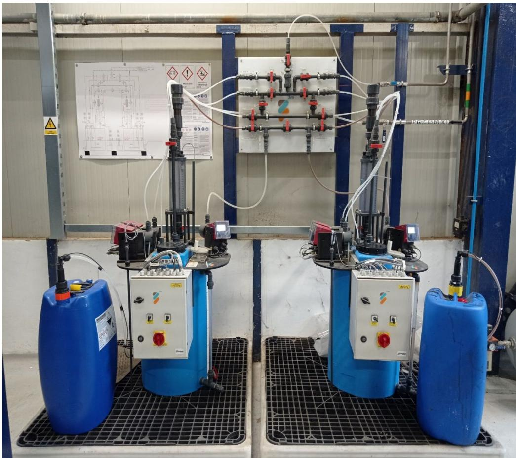
Slika 16. Dozirna stanica niskotlačnog kotla NTK3 [23]
