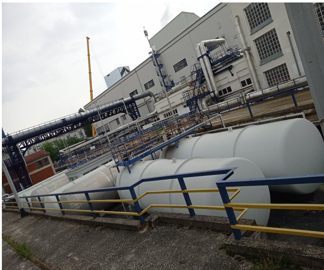
Slika 4. Spremnici solne kiseline i natrijevog hidroksida [8]
