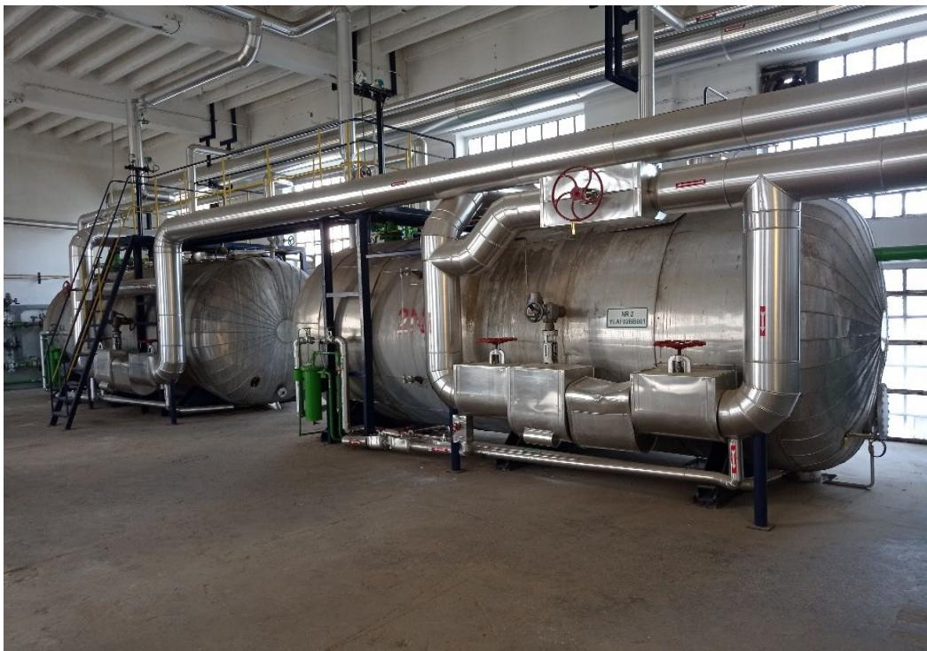
Slika 8. Napojni spremnici vrelovodnog sustava [12]
