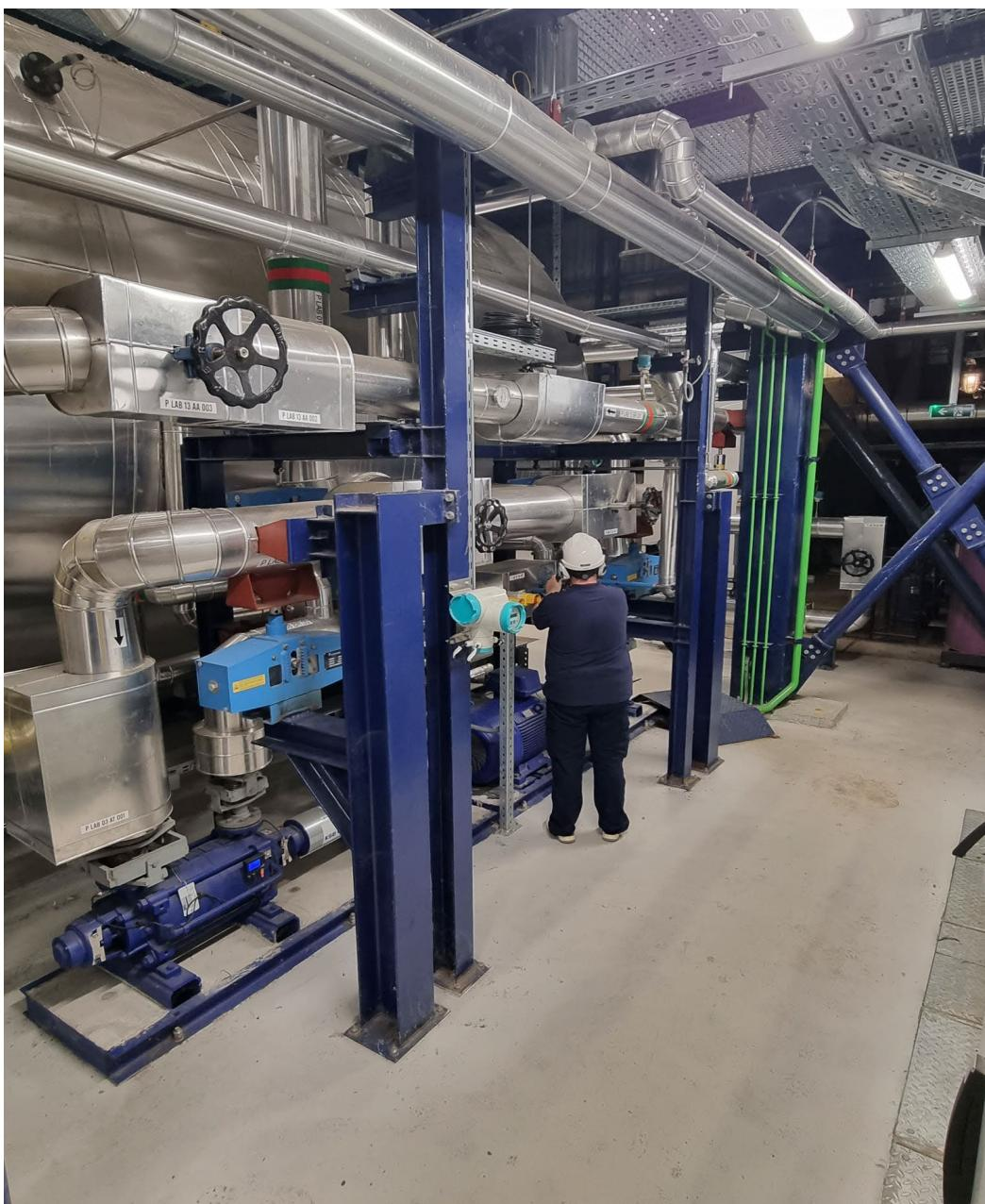
Slika 7. Niskotlačni kotao NTK3 [11]
