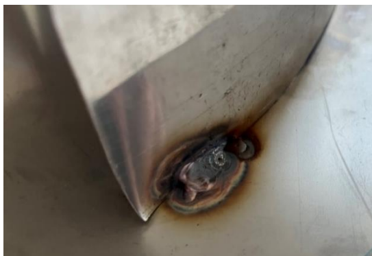
Slika 21: Predodžba problema tijekom zavarivanja. Izvorno autor.
