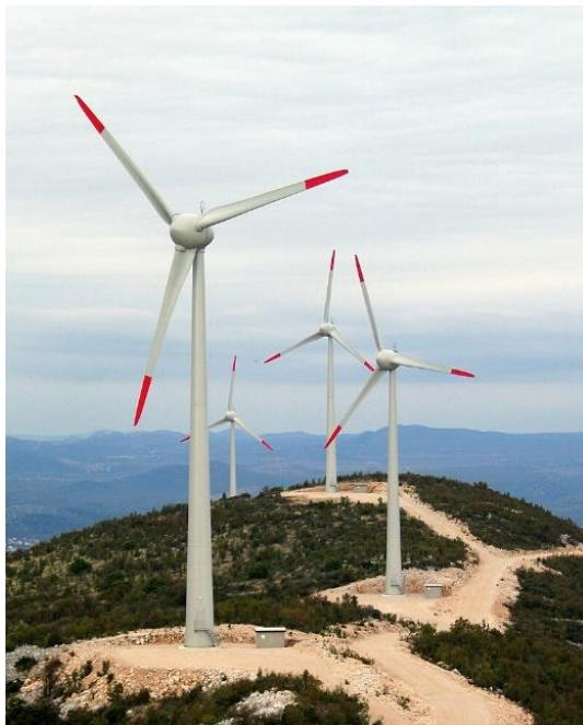
Slika 5: Predodžba vjetroturbine s horizontalnom osi vratila
