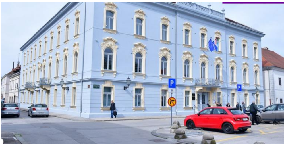
SLIKA 5. Zgrada Gradske uprave Grada Karlovca, Banjavčičeva 9, Karlovac
