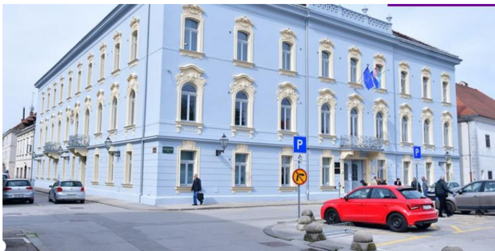
SLIKA 5. Zgrada Gradske uprave Grada Karlovca, Banjavčičeva 9, Karlovac
