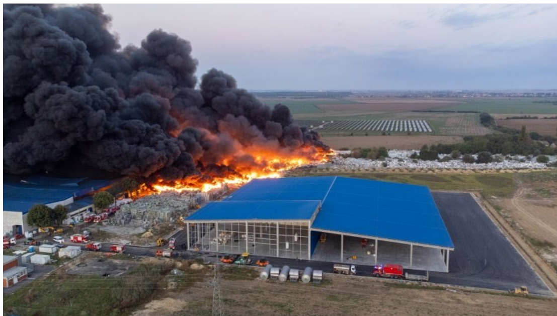
Slika 5 Požar otpadne plastike u Drava International d.o.o.
