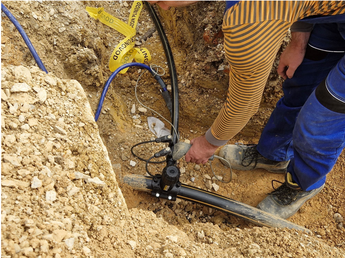
Slika 38. Učitavanje parametara s elektrofuzijske spojnice [Izvorno autor]
