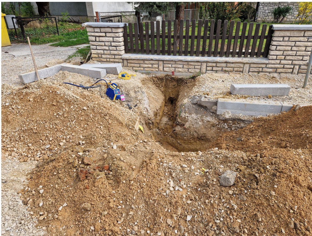
Slika 27. Priprema rova [Izvorno autor]
