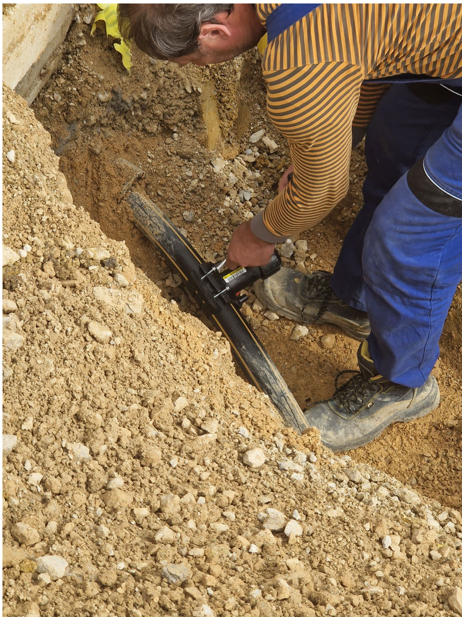
Slika 34. Montiranje sedla [Izvorno autor]
