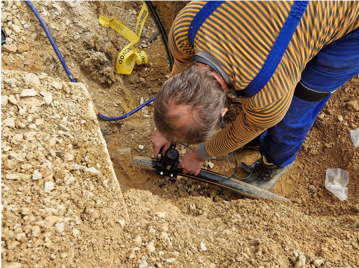
Slika 37. Montiranje kabela na pinove sedla [Izvorno autor]
