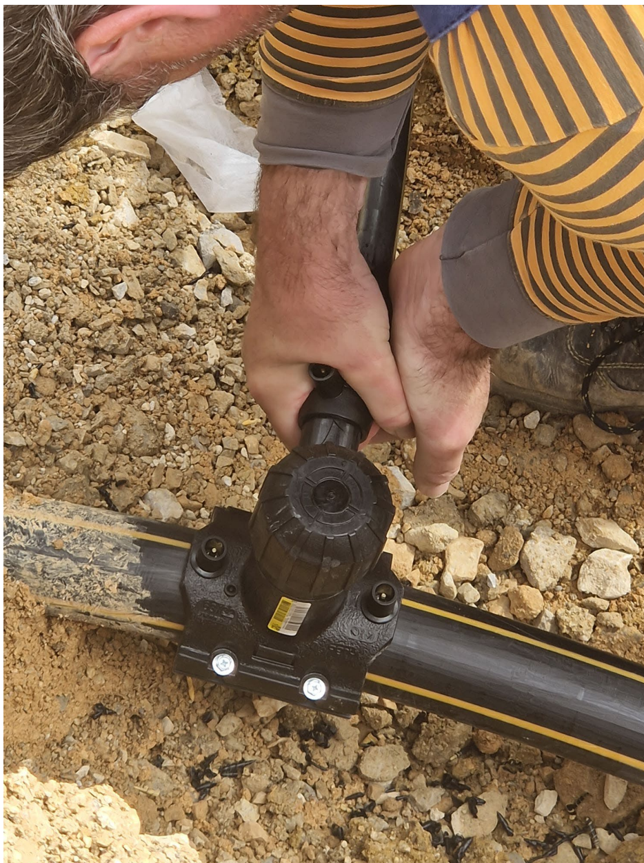
Slika 36. Montiranje elektrofuzijske spojnice na sedlo [Izvorno autor]
