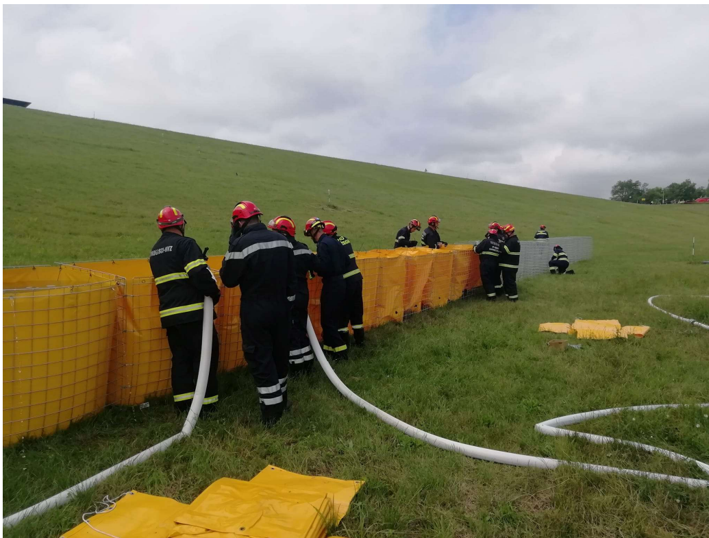
Slika 9 - Vježba SIGURNOST 22, jezero Borovik - postavljanje i punjenje "box" barijera
