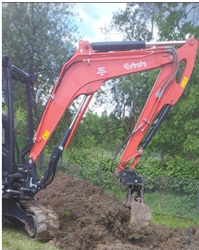
Slika 27. Zatrpavanje kanala pomoću mini bagera
