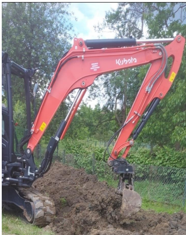
Slika 27. Zatrpavanje kanala pomoću mini bagera
