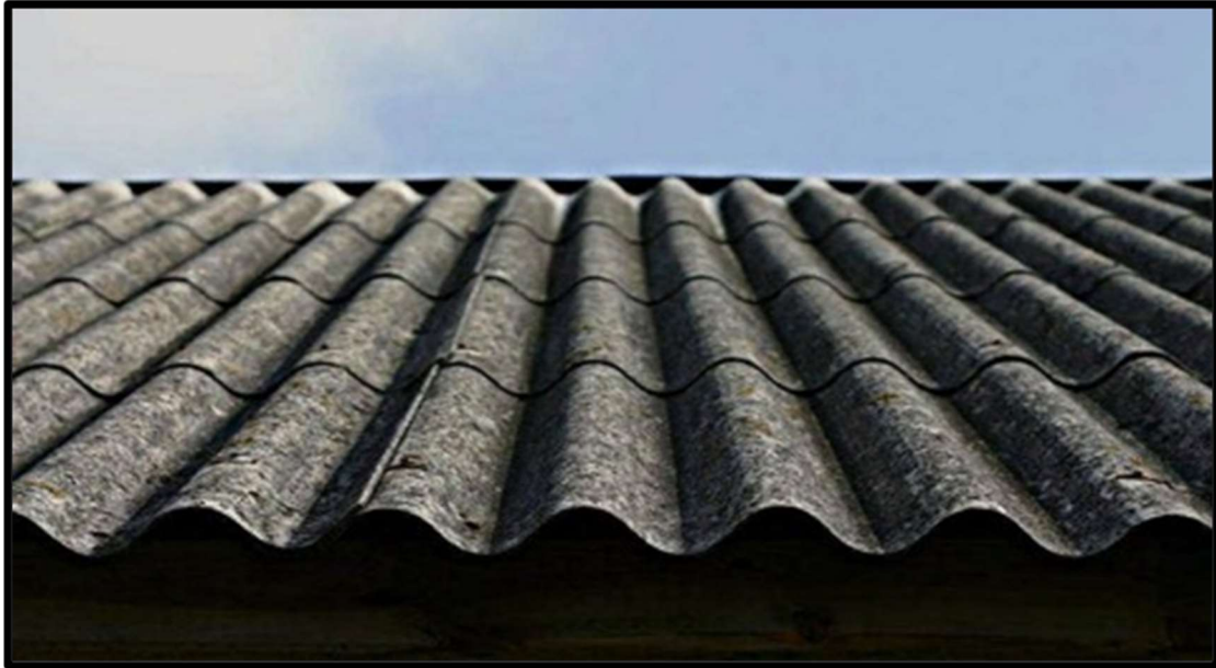
Slika 2 - Primjer azbesta, azbestni krovni pokrov [14].
