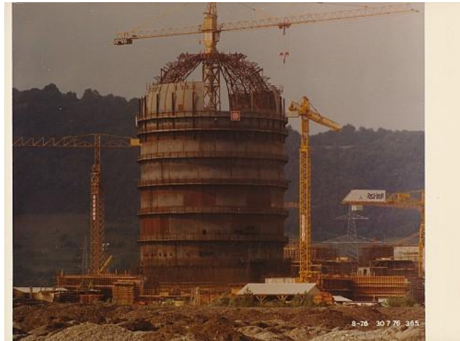
Slika 6 Montaža reaktorskog dijela[11]
