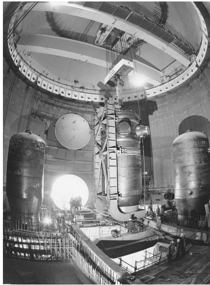
Slika 8 Ugradnja oba parogeneratorska[11]
