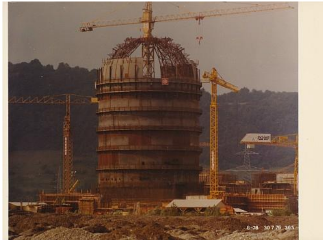
Slika 6 Montaža reaktorskog dijela[11]
