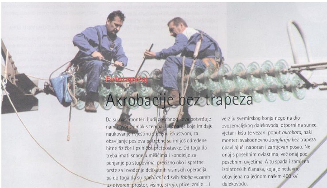
Slika 20: Prikaz montera pri izmjeni izolatora na izolatorskom lancu na stupu
