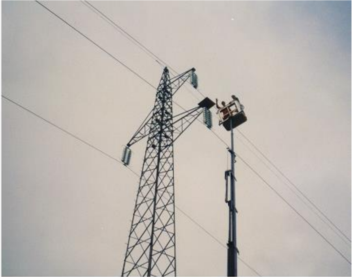
Slika 3: Elektroenergetski nadzemni vod
