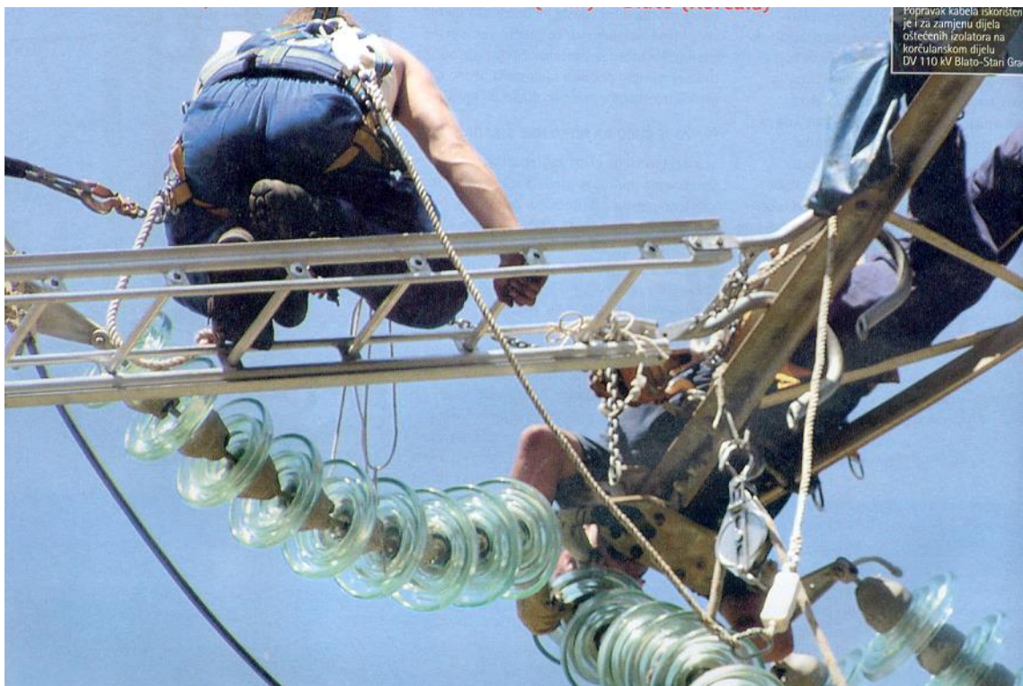
Slika 21: Prikaz zamjene izolatorskog lanca na dalekovodnom stupu
