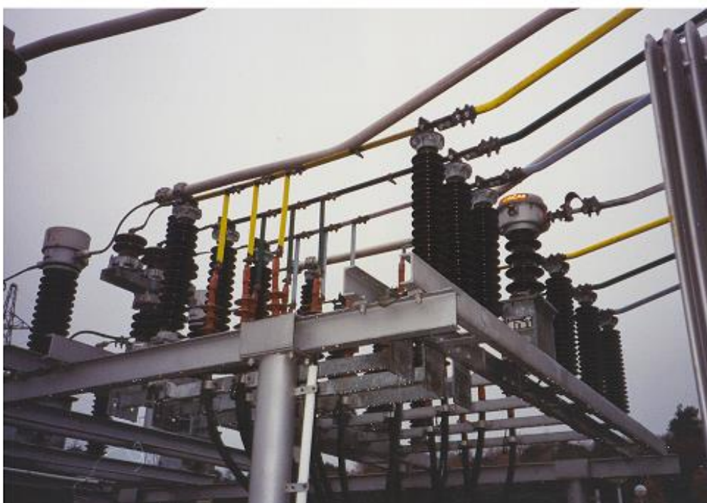
Slika 6: Rasklopno postrojenje
