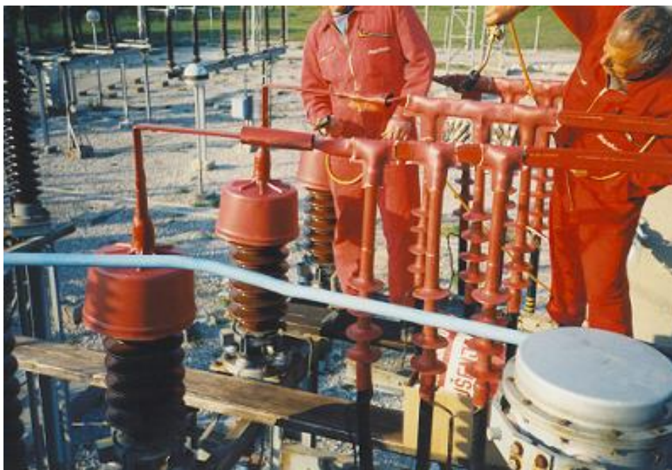
Slika 24: Prikaz izrade izoliranog elektroenergetskog postrojenja
