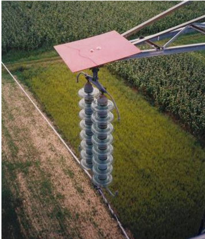
Slika 23: Prikaz zaštite izolatorskog lanca od životinja
