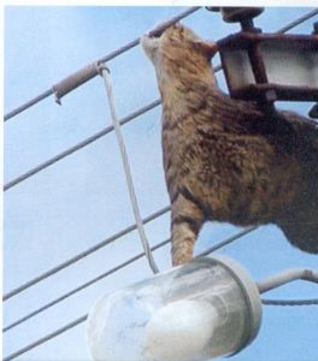
Slika 15: Prikaz dozemnog spoja izazvan mačkom
