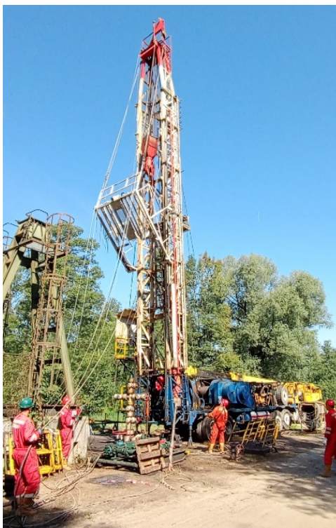
Slika 23. Spuštanje tornja na RP NAT-3 [3]
