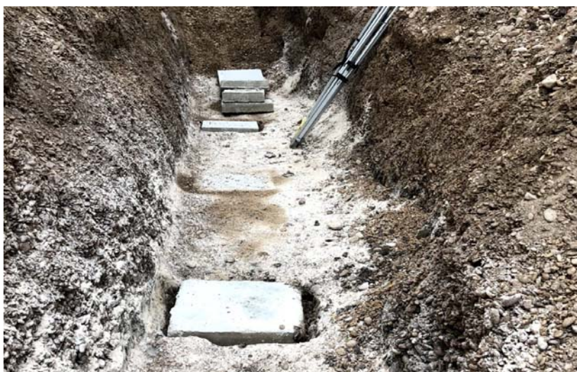
Slika 37: Iskopan rov sa sidrenim (betonskim) blokovima [33]
