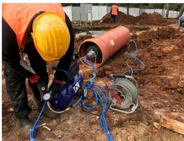
Slika 43: Kompresor za tlačno ispitivanje cijevi [34]
