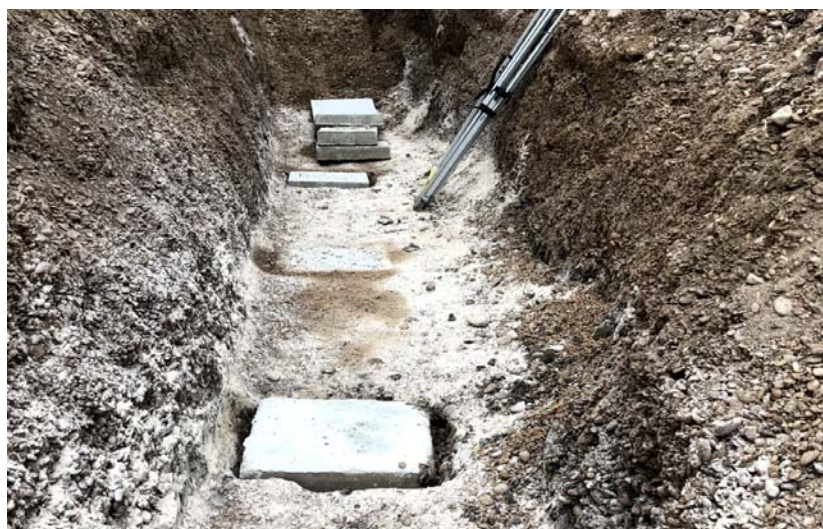
Slika 37: Iskopan rov sa sidrenim (betonskim) blokovima [33]
