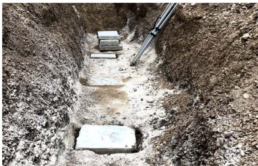
Slika 37: Iskopan rov sa sidrenim (betonskim) blokovima [33]
