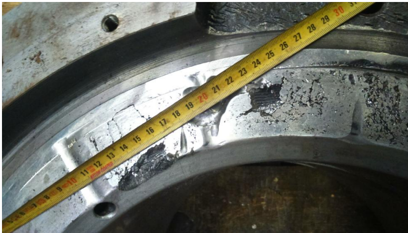
Slika 61a i 61b: Stanje ležaja prije reparacije
