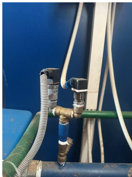
Slika. 10 Montiran senzor tlaka Izvor: Autor
