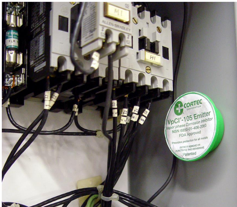
Slika 33. Inhibitor koroziije u razvodnom ormaru. [17]
