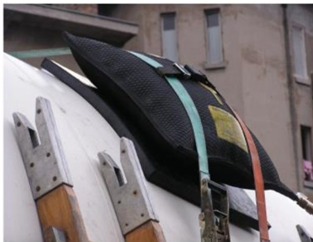
Slika 12. Pukotina zabrtvljena pneumatskima jastukom [8]
