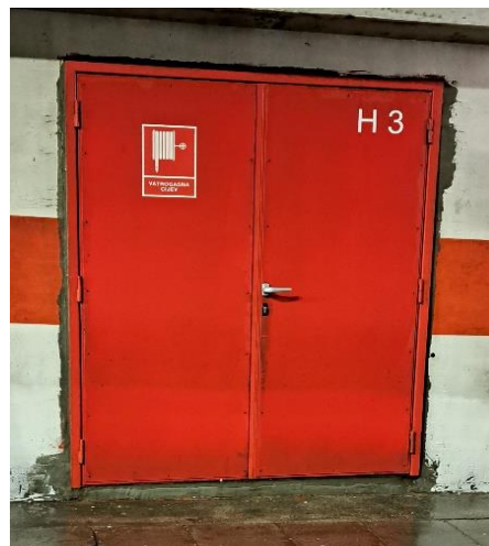
Slika 7. Hidrantska niša u tunelu Sv. tri Kralja [11]
