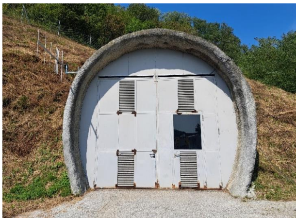
Slika 9. Ulaz u servisnu cijev tunela Sv. tri Kralja [11]
