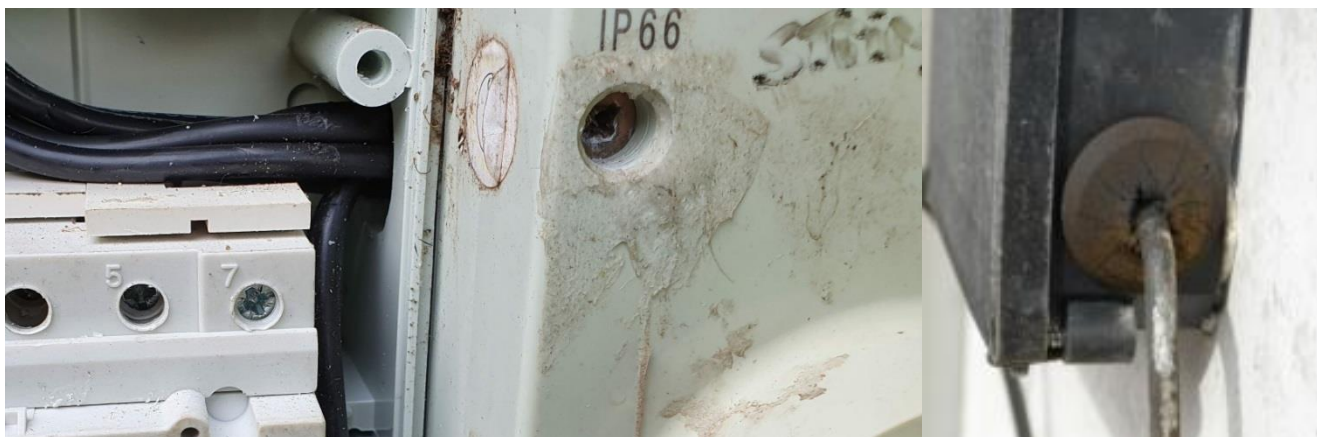
Slika 13. Prodor vlage u kućište zbog neodgovarajuće brtve [7]
