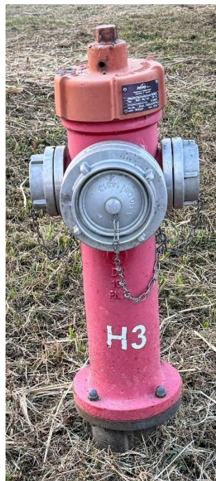
Slika 10. Nadzemni hidrant [19]
