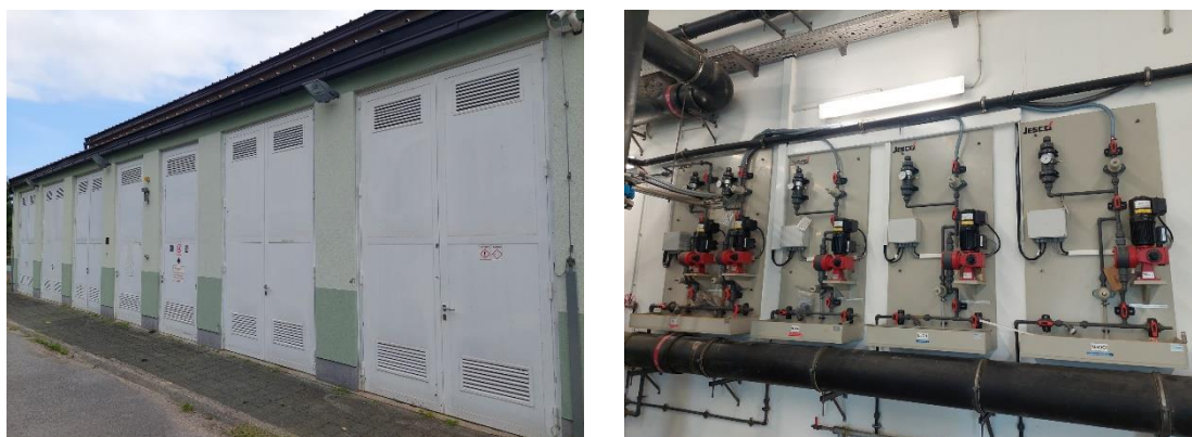
Slika 14: a) Spremište kemikalija; b) Dozirne pumpe za kemikalije (autorske slike)
