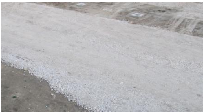
Slika 9. Korištenje recikliranim agregatima [12]
