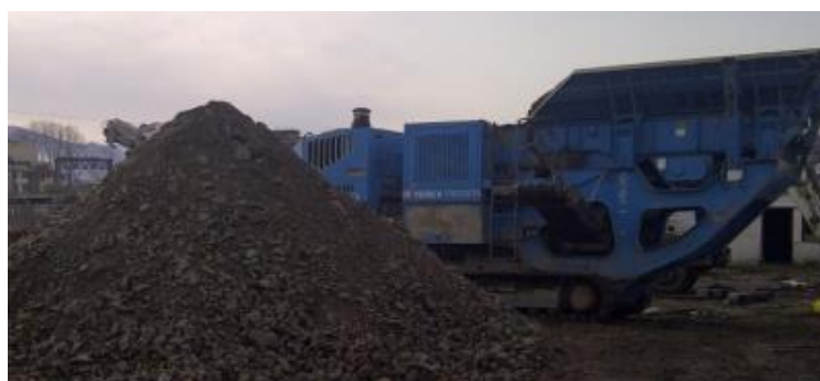
Slika 7. Drobljenje konstrukcijskog betona na licu mjesta [12]
