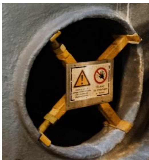
Slika 35. Oznaka blokiranog ulaza u spremnik [1]
