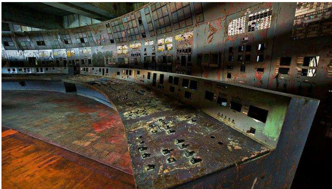
Slika 17: Kontrolna soba Nuklearne elektrane Černobil [10].
