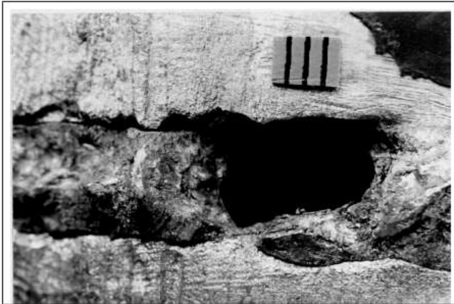
Slika 14. Primjer selektivne korozije Cr-Ni čelika. Pripajanje prije zavarivanja provedeno je “nekorektno” [7]
