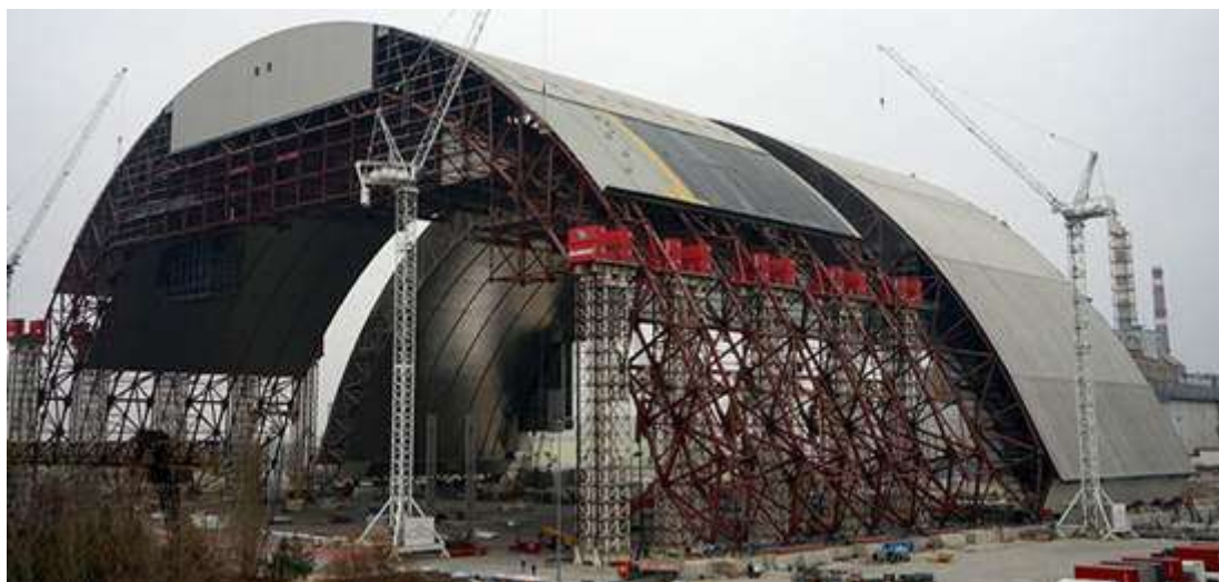
Slika 19: Čelična zaštita iznad reaktora 4 u Černobilu [11].
