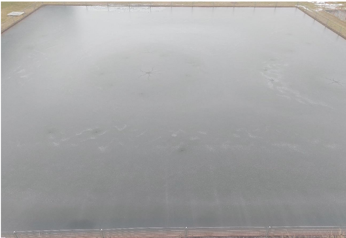
Slika 4. Bazen za protupožarnu vodu [3]
