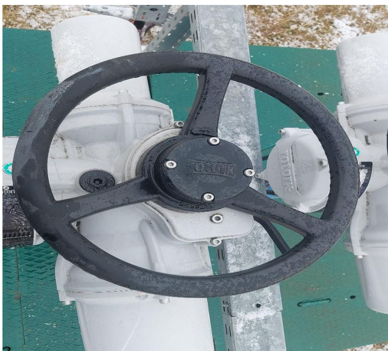
Slika 22. Ručno upravljanje ventilom [3]
