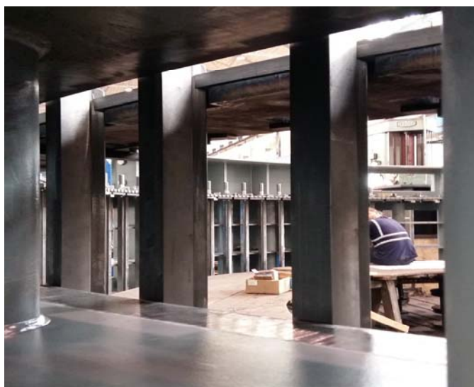
Slika 13. Postavljanje trapeznih letvi [9]
