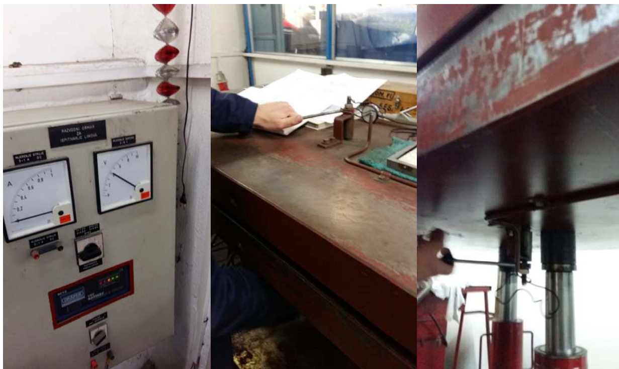
Slika 36. Razvodni ormar za postupak mjerenja limova, te gornji i donji „šiljak“ na pločama preše [9]
