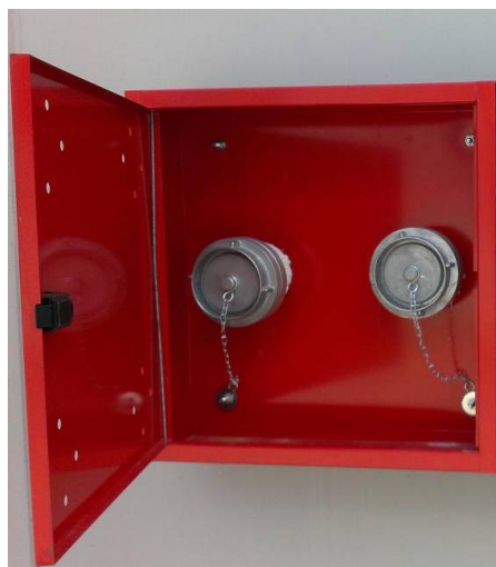
Slika 33. Predodžba priključka sprinkler sustava na vatrogasno vozilo
