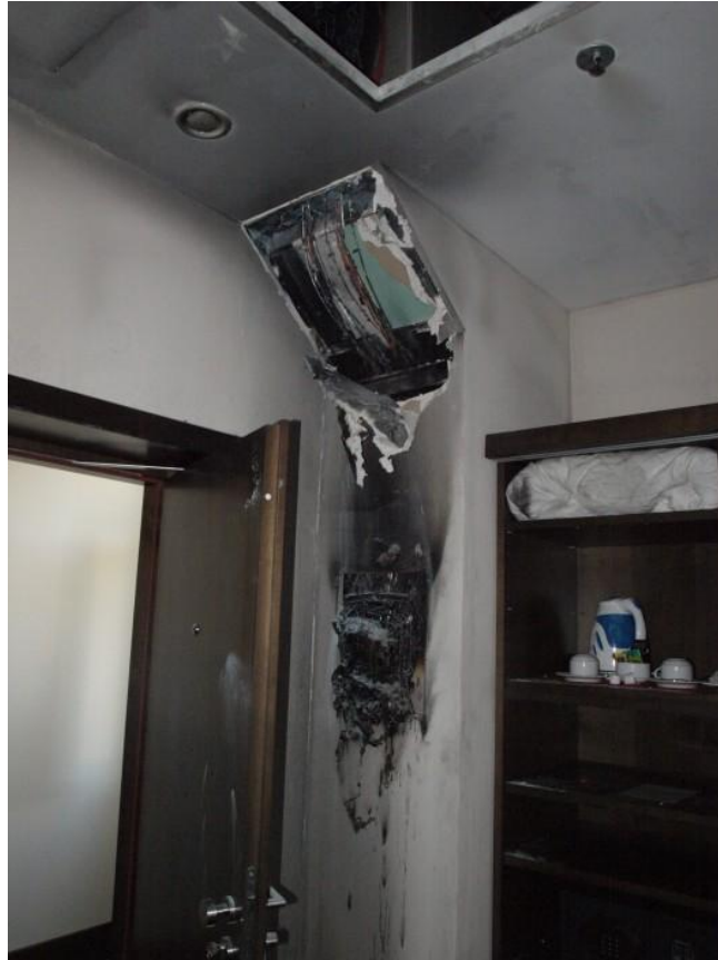
Slika 14. Predodžba požara ugašenog jednom sprinkler mlaznicom
