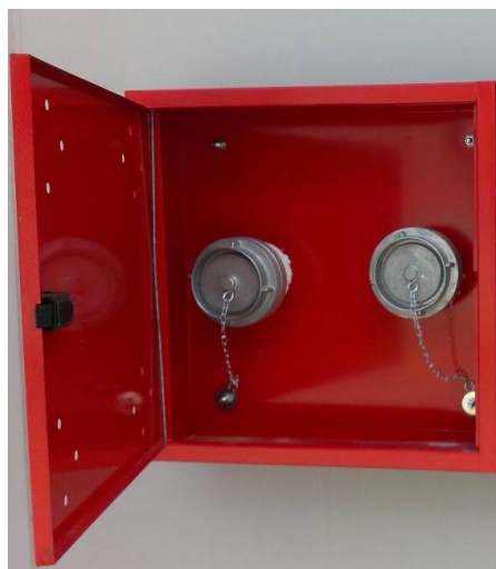
Slika 33. Predodžba priključka sprinkler sustava na vatrogasno vozilo
