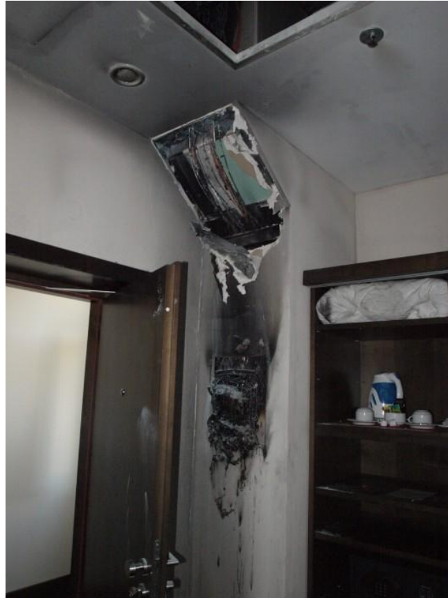
Slika 14. Predodžba požara ugašenog jednom sprinkler mlaznicom
