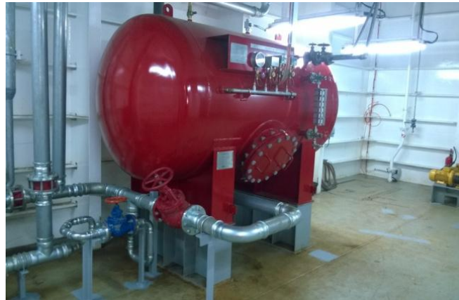
Slika 32. Predodžba tlačnog spremnika za sprinkler sustav
