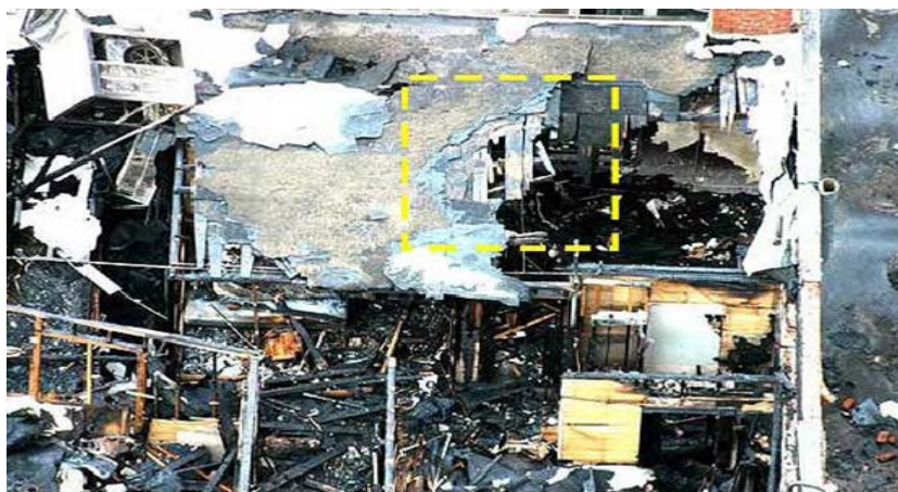
Slika 13: Pogled iz zraka na krov zgrade [23].
