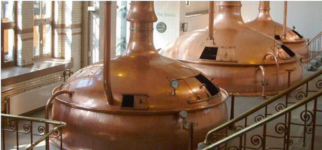
Slika 6. Kotlovi za kuhanje sladovine
