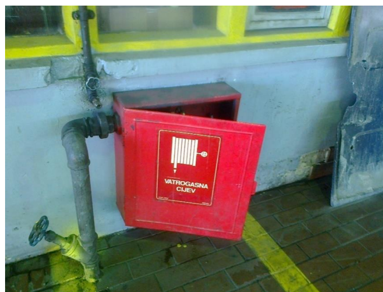
Slika 15. Unutarnji hidrant
