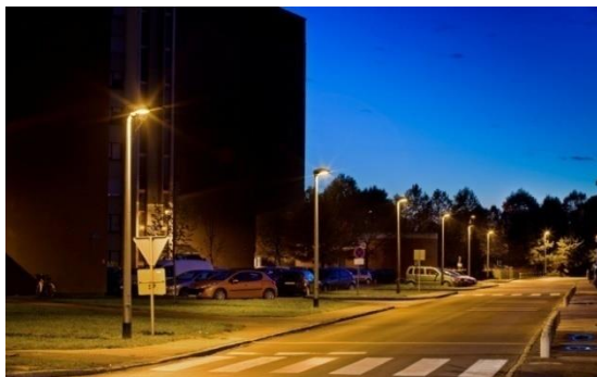
Sl. 18. Javna rasvjeta za cestovni promet[3]
