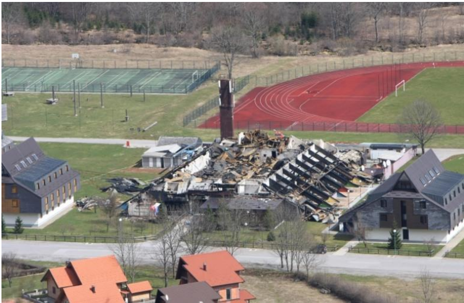
Slika 6. HOC Bjelolasica nakon požara 2011.
