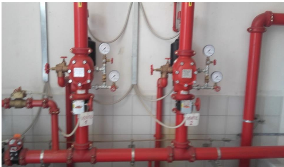
Slika 22. Splinkler instalacija [izrada autora]
