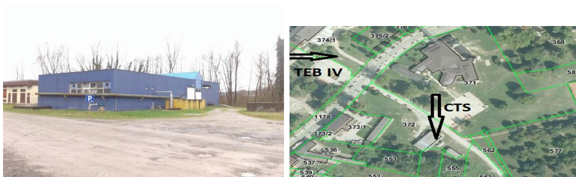
Slika 21. Centralna toplinska stanica.
